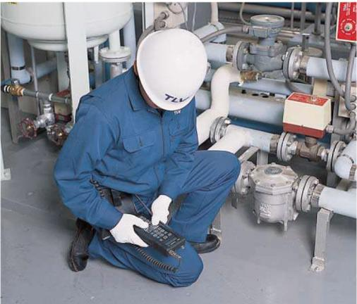
Les données nécessaires à la gestion des purgeurs - type de purgeur, dimension, type de raccordement, pression de fonctionnement, état de fonctionnement, etc. - peuvent être inscrites et mémorisées dans le carnet de gestion.
